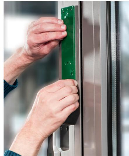
**Es ist unbedingt darauf zu achten, daß der mechanische Auslöseweg des Treibriegels bis zu seinem Endanschlag gewährleistet ist. Der GfS Flügelwächter® und seine Montagehilfen müssen nach Auslösung den Betätigungsweg des Treibriegels komplett freigeben.**
