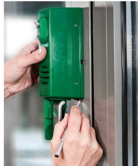
1a. **Wenn Sie die Klebeplatte verwenden:** Reinigen Sie den Rahmen gründlich indem Sie Fett und Staub entfernen, ziehen die Schutzfolie von der Klebefläche und befestigen Sie die Platte nach Ihren Markierungen auf dem Rahmen. Drücken Sie die Klebeplatte für ca. 10 – 15 Sekunden fest an.
